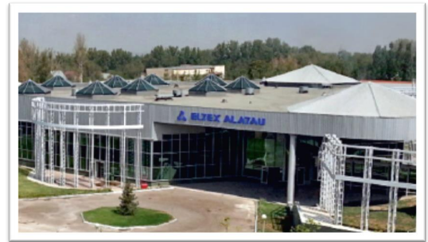
Производственный комплекс в Казахстане, в Алматы
